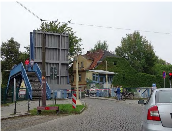
An der Schleuse
